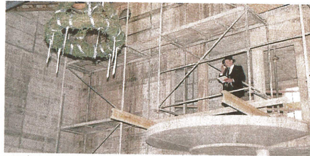
Ein Zimmerer hält den Richtspruch im Rohbau.
