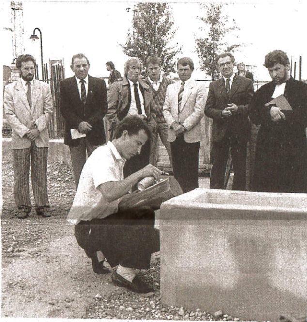
Baustart: Mit der Grundsteinlegung im Sommer 1987 beginnt die Errichtung der Kirche.
